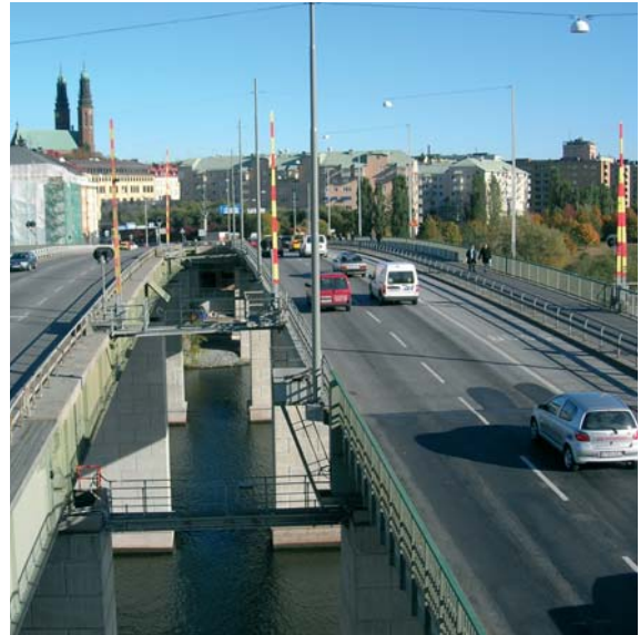
Liljeholmin silta keskellä Tukholmaa on tärkeä osa kaupungin tieverkostossa. Vanhin osa sillasta on vuodelta 1928 ja toinen osa vuodelta 1954.
